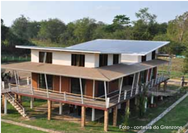
Sistema Fotovoltáico Solar Sistema de 10kWp da Grezone utilizando KRISTILE
