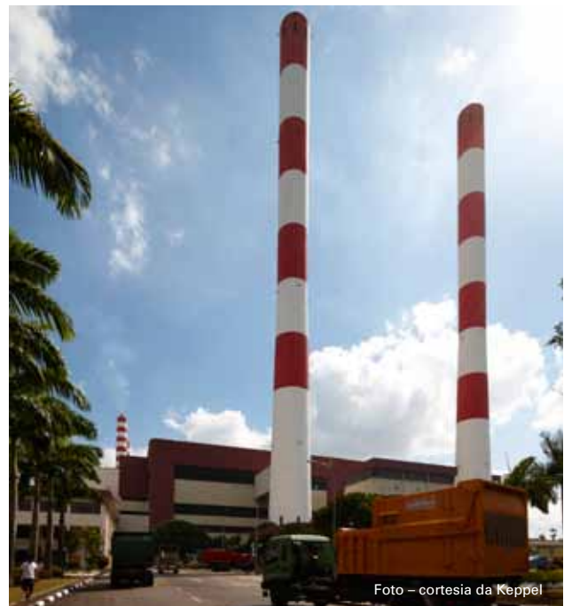
Senoko Waste-to-Energy Plant, Singapore: de propriedade e administrada pela Keppel Integrated Engineering (KIE), a Senoko Waste-to-Energy Plant tem a capacidade para tratar 2.400 toneladas de resíduos por dia, gerando mais de 55MW de energia. Juntamente com a Keppel Seghers Tuas Waste-to-Energy Plant, KIE terá capacidade para tratar até 47.6% do volume total de resíduos enviado para incineração 1 em Cingapura.
