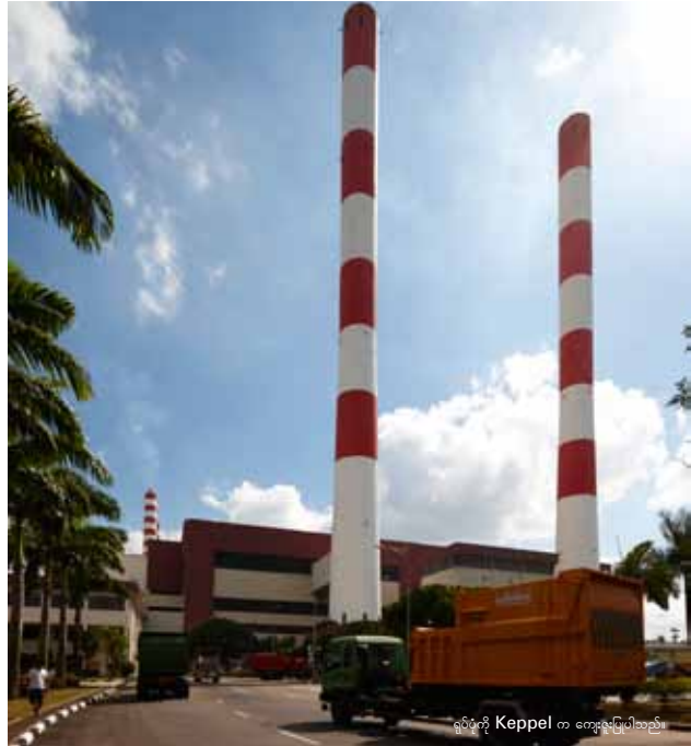
Senoko စွန့်ပစ်ပစ္စည်းမှ စွမ်းအင်အဖြစ် ပြောင်းလဲရေးစက်ရုံ-စင်ကာပူ Keppel ဘက်စုံအင်ဂျင်နီယာ နည်းပညာကုမ္ပဏီ (KIE) က ပိုင်ဆိုင်လည်ပတ်သည့် Senoko စွန့်ပစ်ပစ္စည်းမှ စွမ်းအင်ထုတ်လုပ်ရေး စက်ရုံသည် စွန့်ပစ်ပစ္စည်းတန်ချိန် ၂၄၀၀ အား နေ့စဉ် ပြုပြင်သန့်စင်ပေးကာ လျှပ်စစ်ဓာတ်အား ၅၅ မဂ္ဂါဝပ်ကျော်ကို ထုတ်လုပ်ပေးလျက်ရှိသည်။ Keppel Seghres Tuas စွန့်ပစ်ပစ္စည်း အသုံးပြု စွမ်းအင်ထုတ်လုပ်မှုစက်ရုံနှင့်အတူ စင်ကာပူနိုင်ငံ၏ မီးရှို့ဖျက်ဆီးရမည့် အမှိုက်ပမာဏ ၄၇ ဒဿ ၆ ရာခိုင်နှုန်းကို KIE က သန့်စင်ပြုပြင်ပေးနိုင်စွမ်းရှိသည်။
