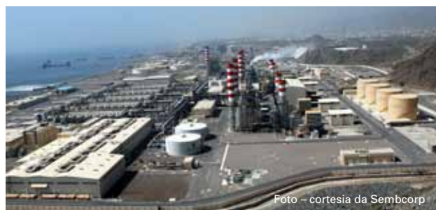
Fujairah Independent Water and Power Plant (IWPP), UAE: Como a maior planta híbrida mundial operacional de dessalinização de água tem uma capacidade de dessalinização diária de 100 milhões de galões imperiais de água
