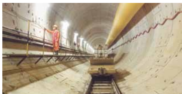
Deep Tunnel Sewerage System: transporta água usada das moradias e indústrias para uma instalação central de recuperação de água por um túnel de esgoto abaixo do solo com 48km de comprimento e 20 à 55 metros de profundidade
