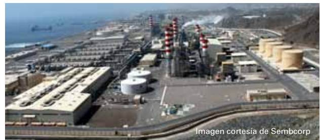
Fujairah Independent Water and Power Plant (IWPP), EAU: En Emiratos Árabes está la mayor planta desalinizadora híbrida del mundo, la IWPP Fujairah tiene una capacidad de desalación de 100 millones de galones imperiales de agua por día.
