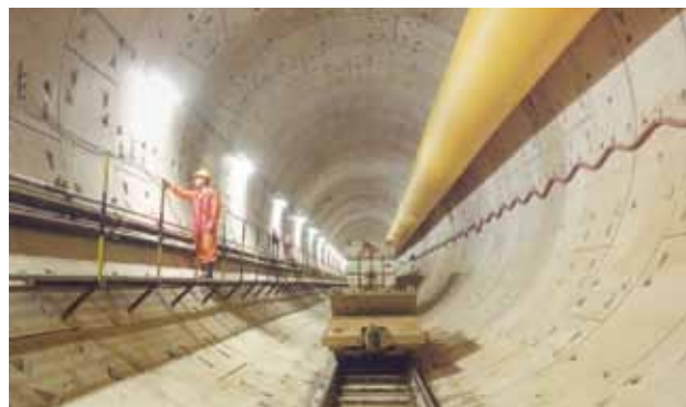
Dự án Hệ Thống Hầm Thoát Nước Sâu (Deep Tunnel Sewerage System)
