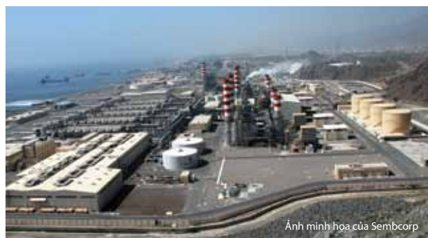
Nhà máy điện-nước độc lập (IWPP), Các Tiểu Vương Quốc Ả Rập Thống Nhất (UAE)
