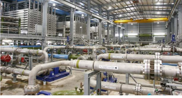
محطة سينجسبرينج لتحلية المياه، سنغافورة تعتبر محطة سينجسبرينج لتحلية المياه، من خلال استخدامها لتقنية التناضح العكسي المتقدمة والفعالة من حي الطاقة والتكلفة، إحدى أكبر محطات تحلية مياه البحر التي تعمل بتقنية الأغشية في آسيا.
