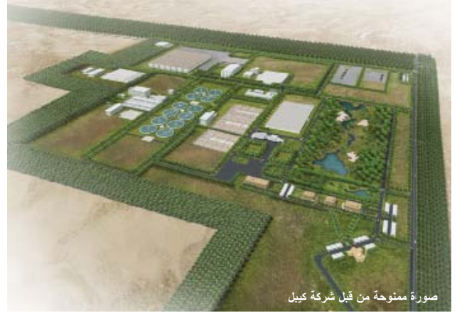
محطة سينجسبرينج لتحلية المياه، سنغافورة تعتبر محطة سينجسبرينج لتحلية المياه، من خلال استخدامها لتقنية التناضح العكسي المتقدمة والفعالة من حي الطاقة والتكلفة، إحدى أكبر محطات تحلية مياه البحر التي تعمل بتقنية الأغشية في آسيا.
