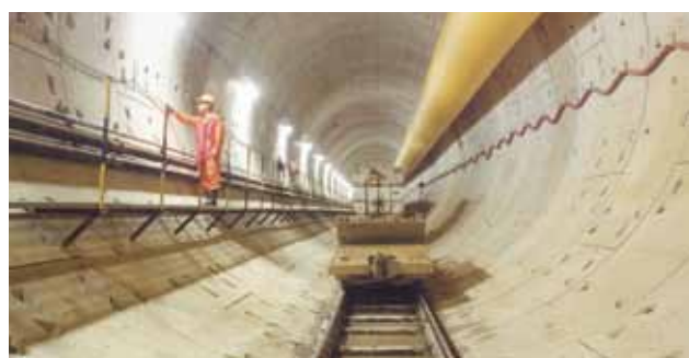
မြေအောက်ဥမင်သုံး ညစ်ညမ်းရေ စွန့်ပစ်မှုစနစ်-စင်ကာပူ နေအိမ်များနှင့် စက်မှုလုပ်ငန်းများတွင် သုံးစွဲသည့်ရေများကို သန့်စင်မှုပြုလုပ်ရေး ညစ်ညမ်းရေ စုစည်းရယူရေးစက်ရုံသို့ ပေးပို့ရန် မြေအောက်အနက် မီတာ ၂၀ မှ ၅၅ မီတာအကြား တည်ရှိသော အရှည် ၄၈ ကီလိုမီတာရှိ ဥမင်လိုက်ခေါင်းကို အသုံးပြုသည်။
